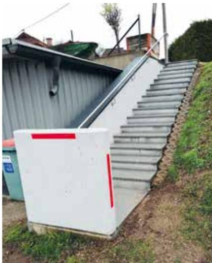
Die in der Zettereier Straße befindliche Stiege (Verbindung Zettereier Straße zum Weizenweg) war aufgrund von Witterungseinflüssen sehr desolat. Daher musste eine Sanierung durchgeführt werden. Die Sanierung wurde durch Anbringung eines neuen Stiegenbelages (Granit) durch die Firma **Fliesenverlegung Hribernig** und in Bezug auf
