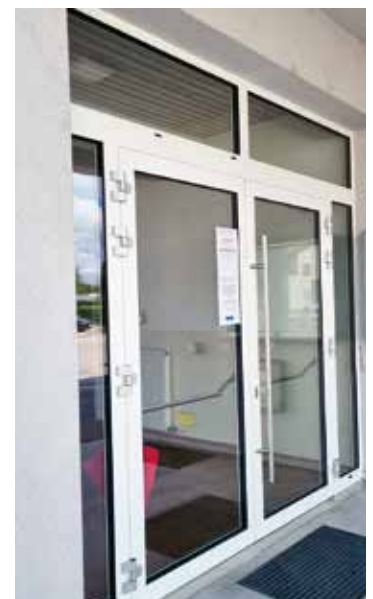
Oben: Errichtung eines Aluportals beim MZH Ebenthal
