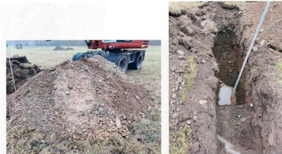
Abbildung 14: Auszug Fotodokumentation Schürfgrube 03 (Quelle: GDP Süd ZT GmbH, Geotechnisches Vorgutachten)
