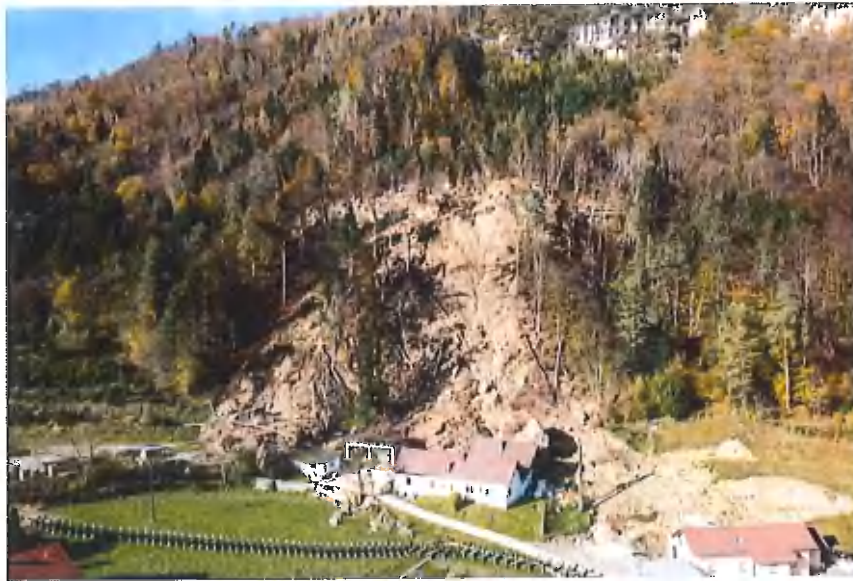
Abb. 2: Übersicht Rutschung Rottenstein (Drohnenbefliegung WLV, 06.11.2023)
