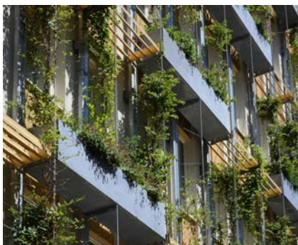
Abb. 47: Troggebundene Fassadenbegrünung
