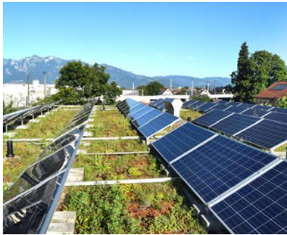
Abb. 45: Gründach und Photovoltaik
