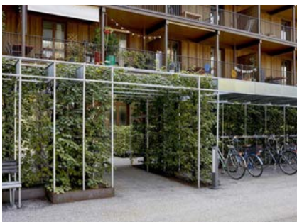
Abb. 34: Überdachte Radabstellanlage bei Hauseingang
