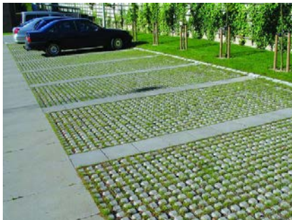
Abb. 32: Stellplätze mit Rasengitter und "Gehstreifen"
