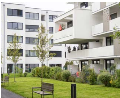
Abb. 77: Eigengärten mit vorgelagertem Abstandsgrün
