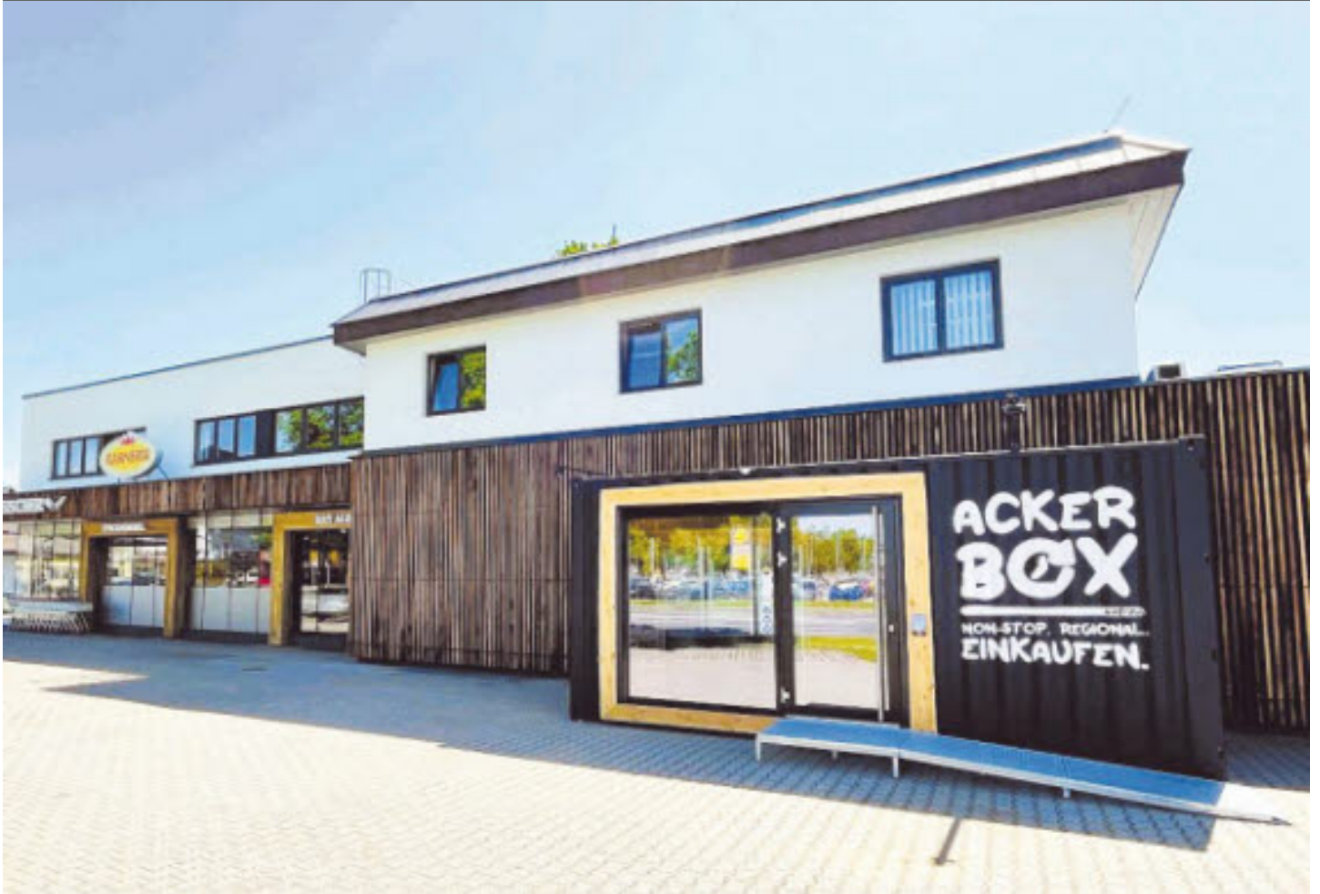
Am Südring wurde Klagenfurts erste Ackerbox aufgestellt KRAINZ
