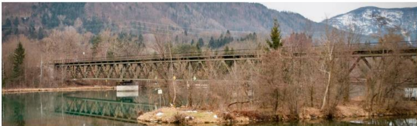
Ein wahres Architekturjuwel: Die Eisenbahnbrücke in Tainach/Stein in Admont: Ein Anrainer spricht von Abriss. ÖBB und Land dementieren die Gerüchte. Sobald die Koralmbahn fährt, sollen hier Radler unterwegs sein.
