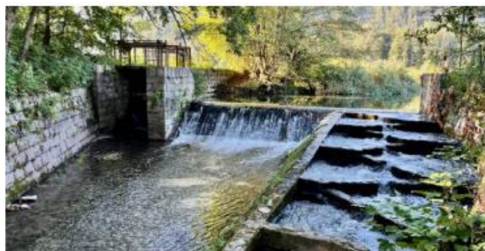
Die Fischwanderhilfe an der Glanfurt war im September nicht „trocken“. Es wurde Anzeige erstattet, da oft zu wenig Wasser fließt. Foto: RegionalMedien
